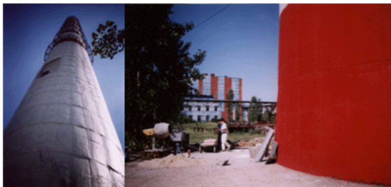
Фот. 2,3 Общий вид дымовой трубы НЛМК (2), общий вид рабочего места по производству монолитного пенобетона
